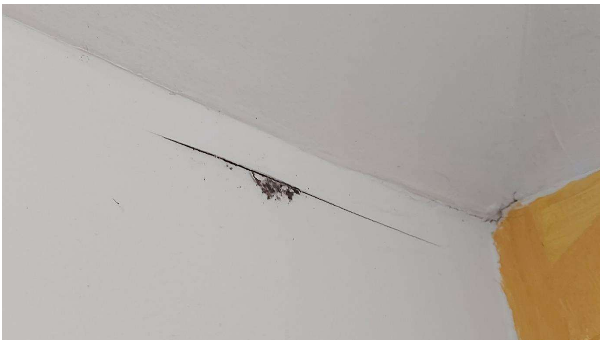
Rez-de-chaussée (chambre) : infiltrations au plafond
