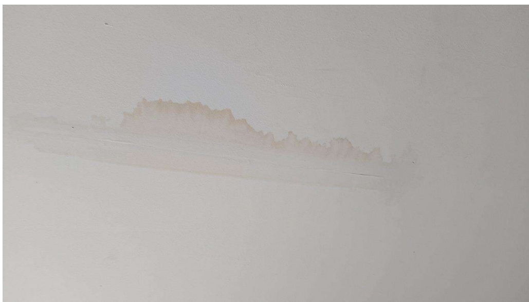
Rez-de-chaussée (chambre) : infiltrations au plafond
